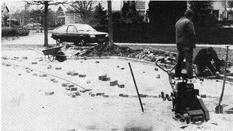
Werkzaamheden aan parkeerplaatsen Sjallemastraat.
