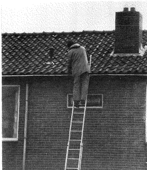
Renovatie-werkzaamheden in de Centrum-weg.
