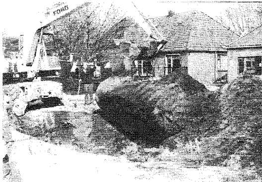
De lekkende opslagtank wordt uit de grond gehaald.
