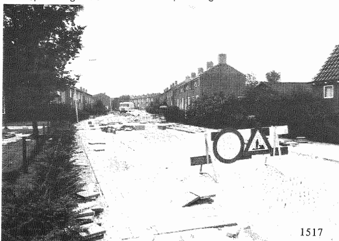
Tijdens de werkzaamheden was het geven en nemen. Hier de Centrumweg op z'n kop.
