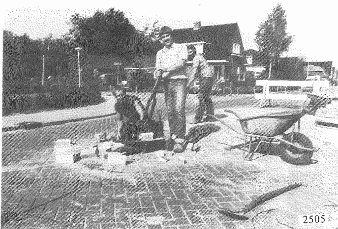
De maatregelen aan de Drachtsterweg hebben er toe geleid, dat deze weg een stuk veiliger is geworden. Hier zijn straatmakers bezig met het maken van de zgn. "druppel" op het kruispunt De Hoge Kamp/Alkemastraat.
