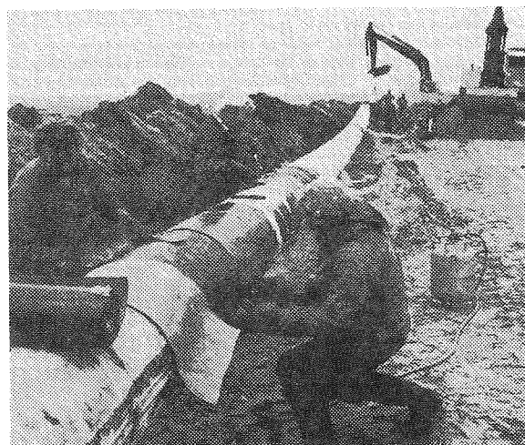
Een beschermende laag wordt aangebracht.
