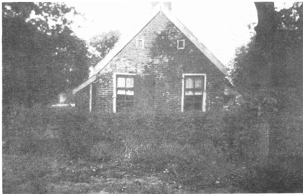
Het reeds afgebroken huisje van Bouwe Helbig aan de Parkweg. Het stond ten noorden van de woning van K. Brandsema.
