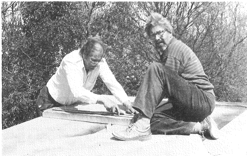
De heren Bekkema en Van der Woude bezig met de dakbedekking.
