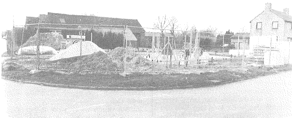
Bouwcombinatie Alserda/Notebomer is inmiddels gestart met de nieuwbouw van de Rabobank aan de Provincialeweg te Opende. De geplande oplevering vindt in september a.s. plaats.
