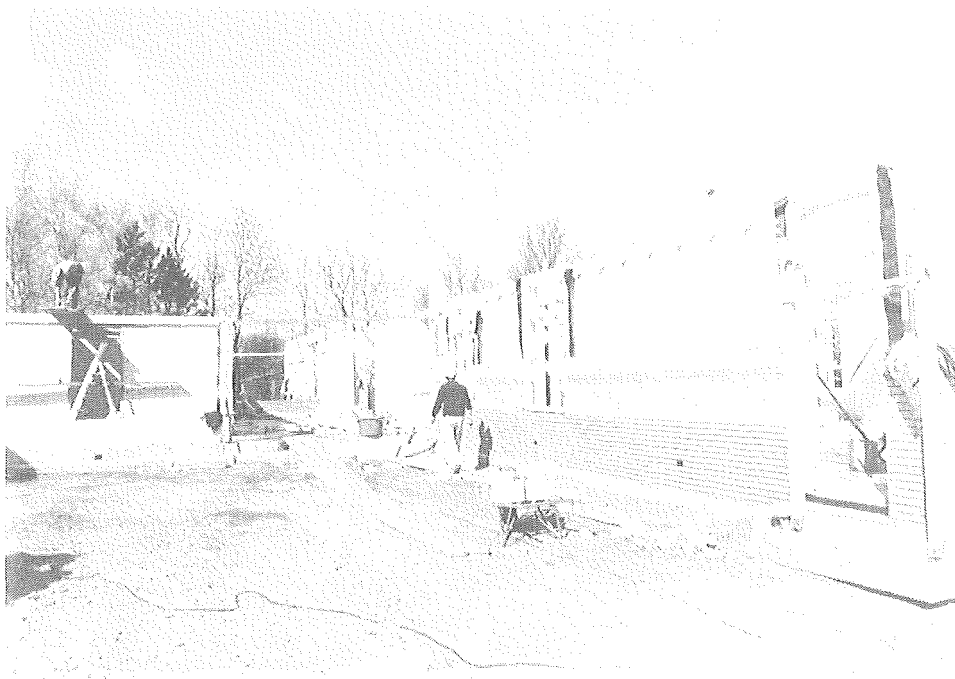
De nieuwbouw van het nieuwe Multi-funktioneel Centrum achter het gymnastiekgebouw krijgt steeds meer vorm. Ondanks de tegenvallende deelname van vrijwilligers zal de ingebruikname bij aanvang van het nieuwe seizoen door kunnen gaan.
